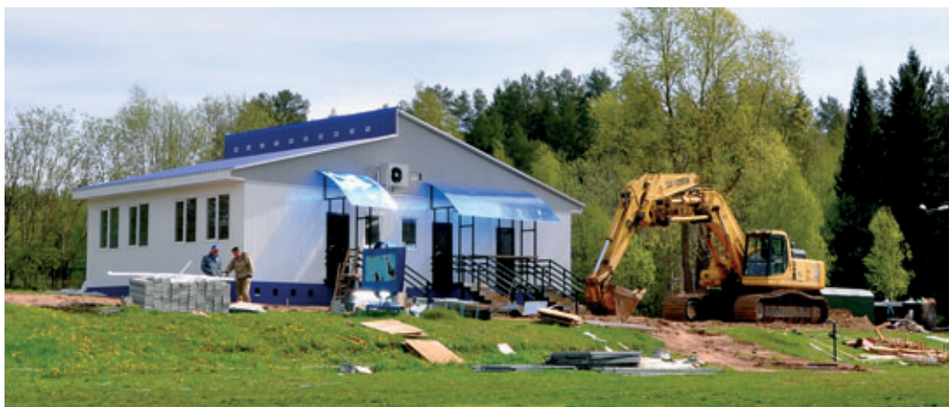
Строительство медицинского пункта
