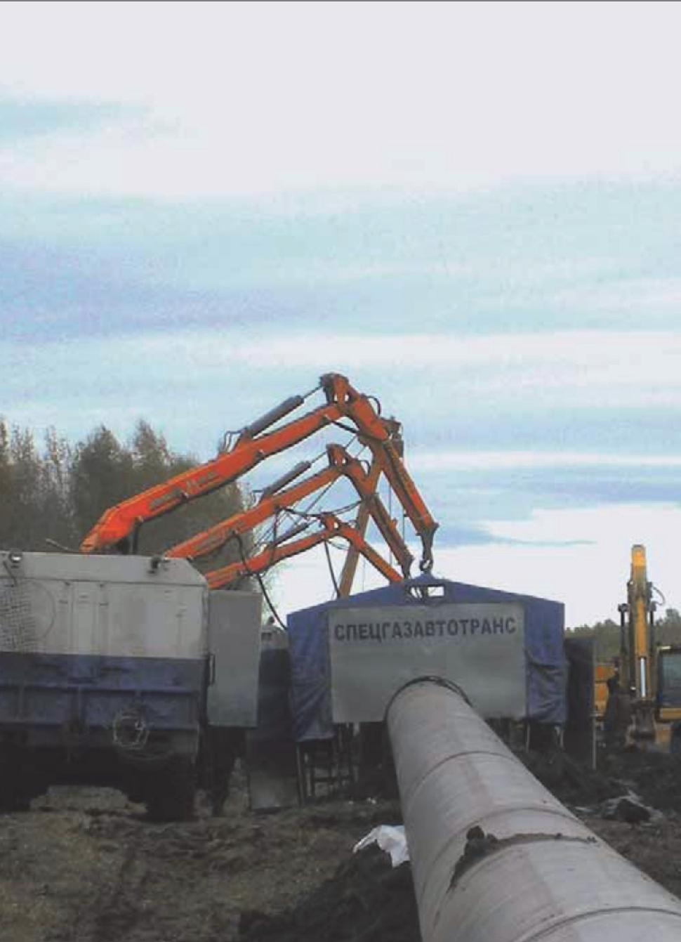
торые он проходит сверху вниз. Применение нового оборудования позволяет сократить время сварки одного стыка в два раза. Повышается и качество.
