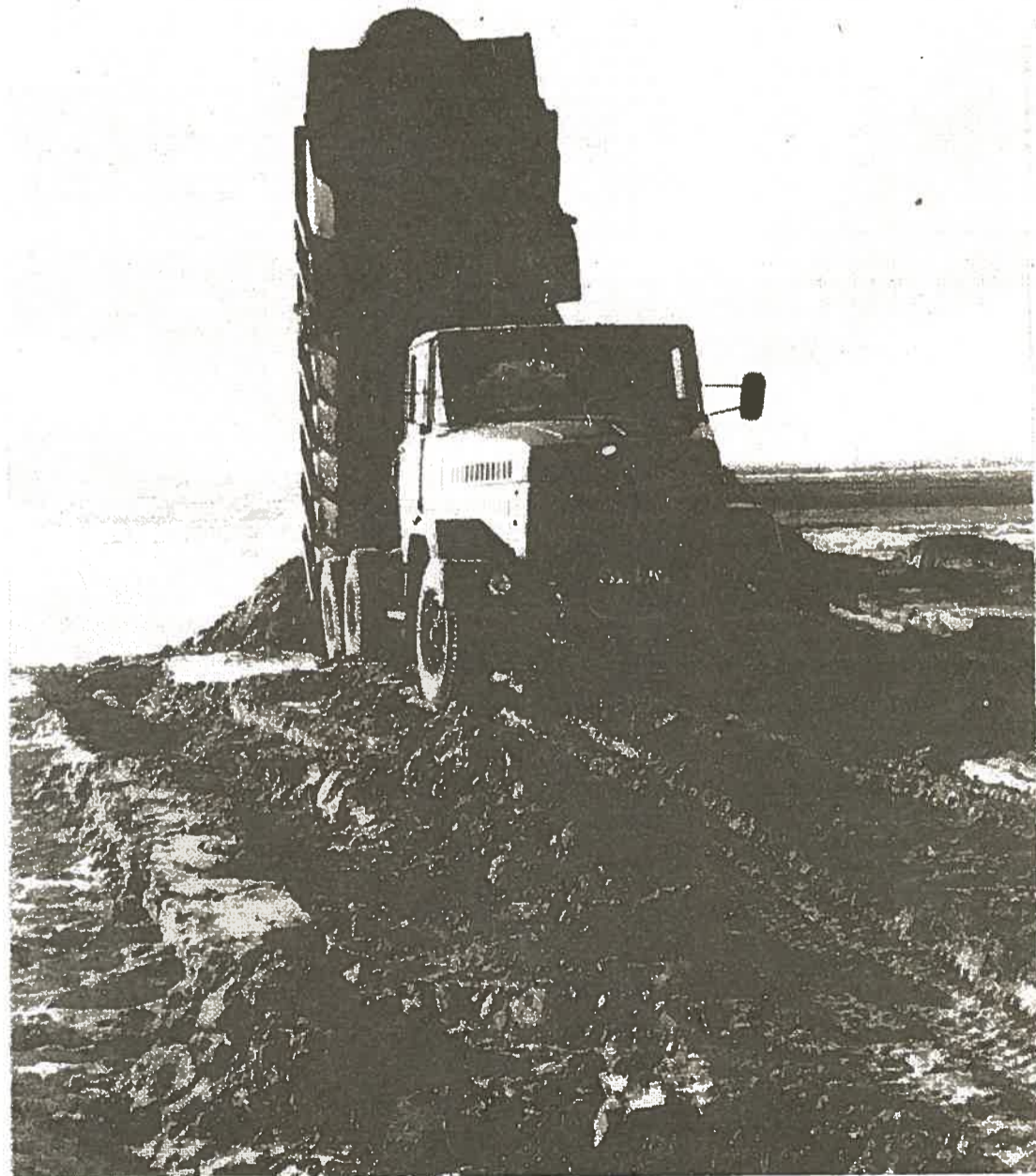
На снимке: все дальше в снежную тундру Харвуты уводят насыпь новой дороги водители Ижевского АТП.
