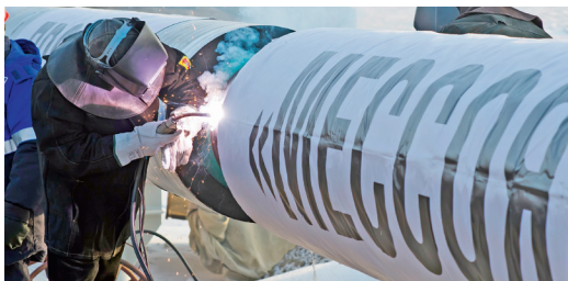
Сварка первого стыка нефтепровода на Месоаяхском нефтегазоконденсатном месторождении
