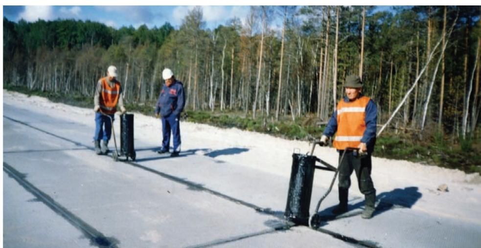
Заливка швов дорожной плиты. 2002 г.
