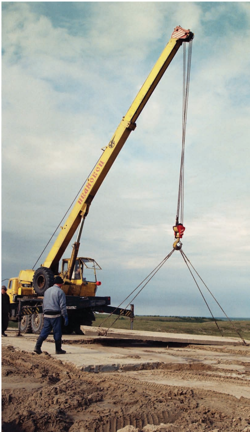
Укладка дорожной плиты
