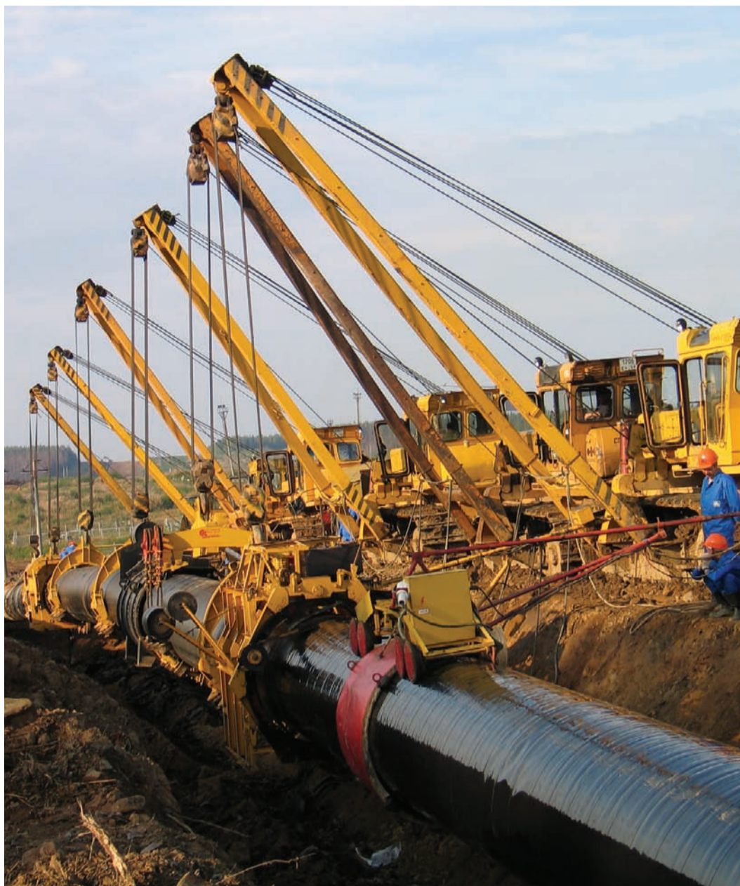
Капитальный ремонт газопровода
