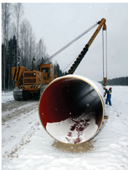
Подготовка трубы к сварке
