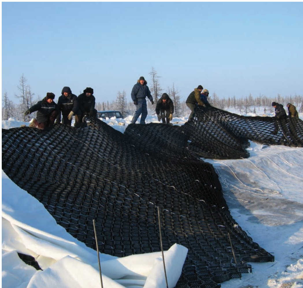
Усиление откосов дороги георешеткой
