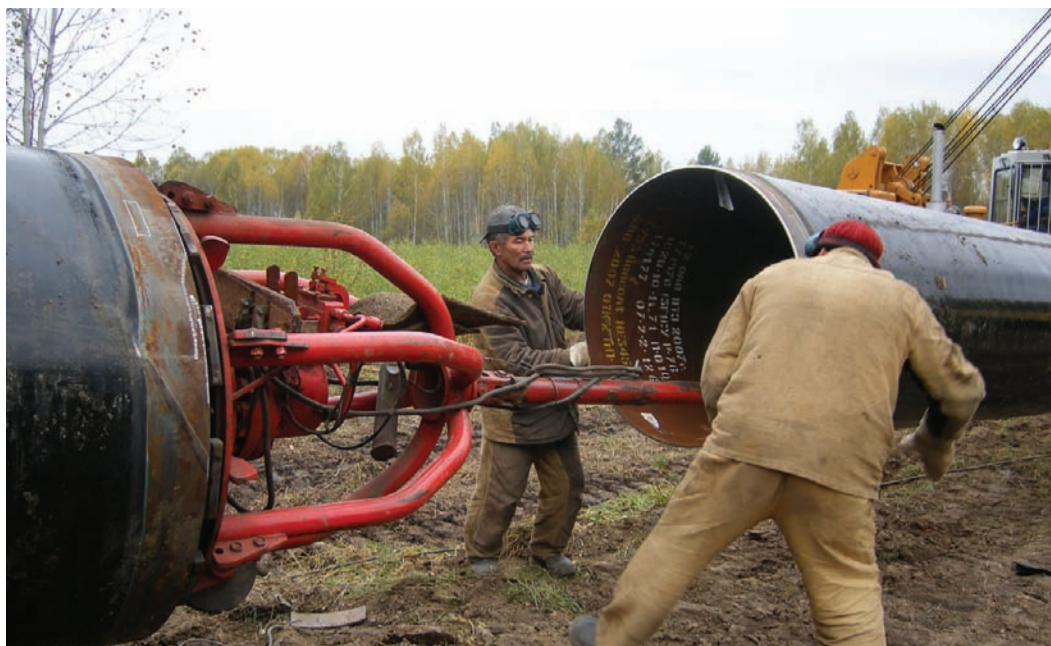
Стыковка трубы
