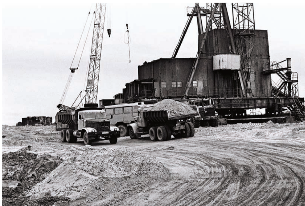
Отсыпка грунта. Ямбург, 1985 г.
