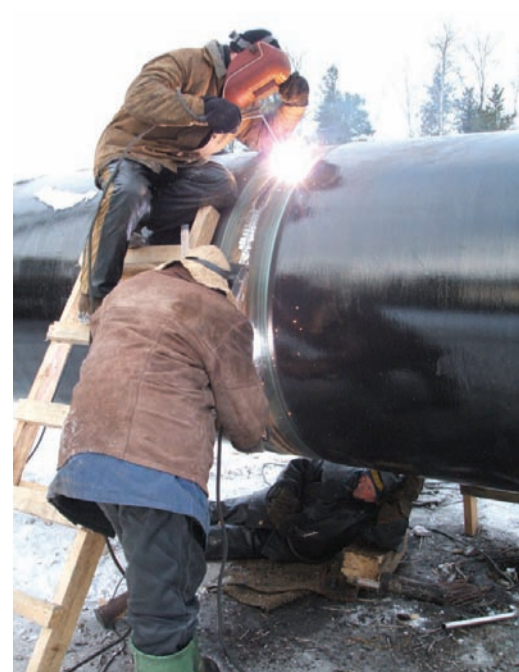
Врезка трубы
