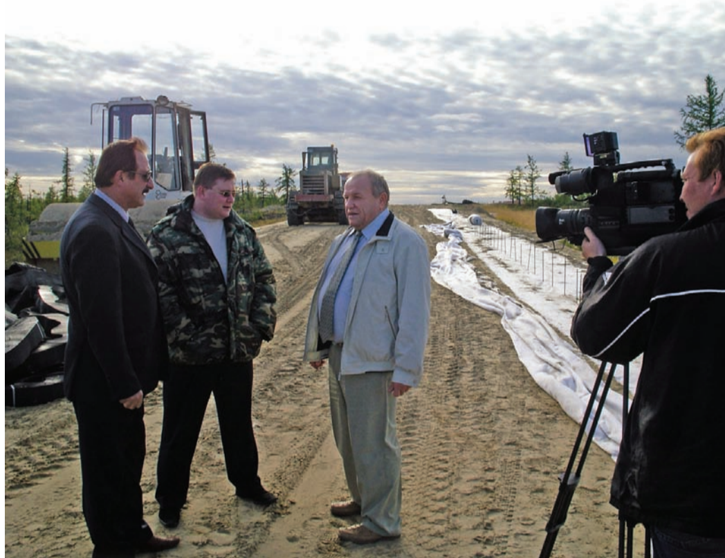
Строительство автодороги Тазовский - Заполярное
