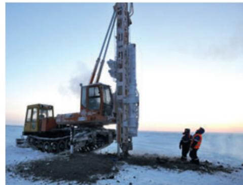
Бурение для установки опор для трубопровода
