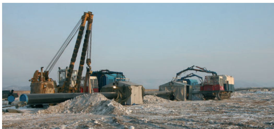
Строительство ГТС «Сахалин – Хабаровск – Владивосток»
