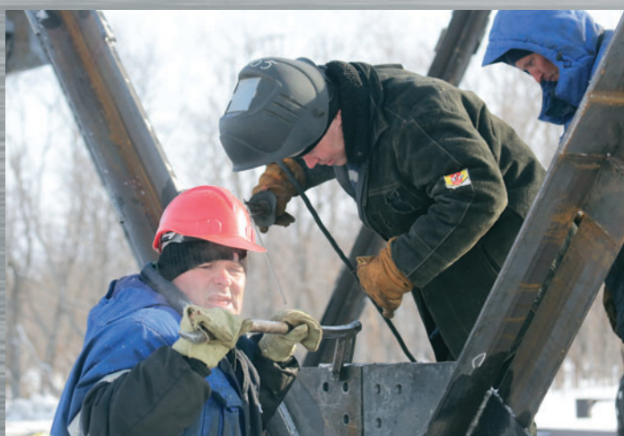
Сварочно-монтажные работы на фасадной части мостовой конструкции
