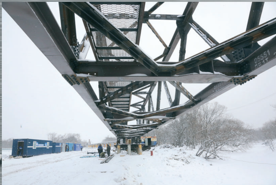
80-тонная секция ферменного моста
