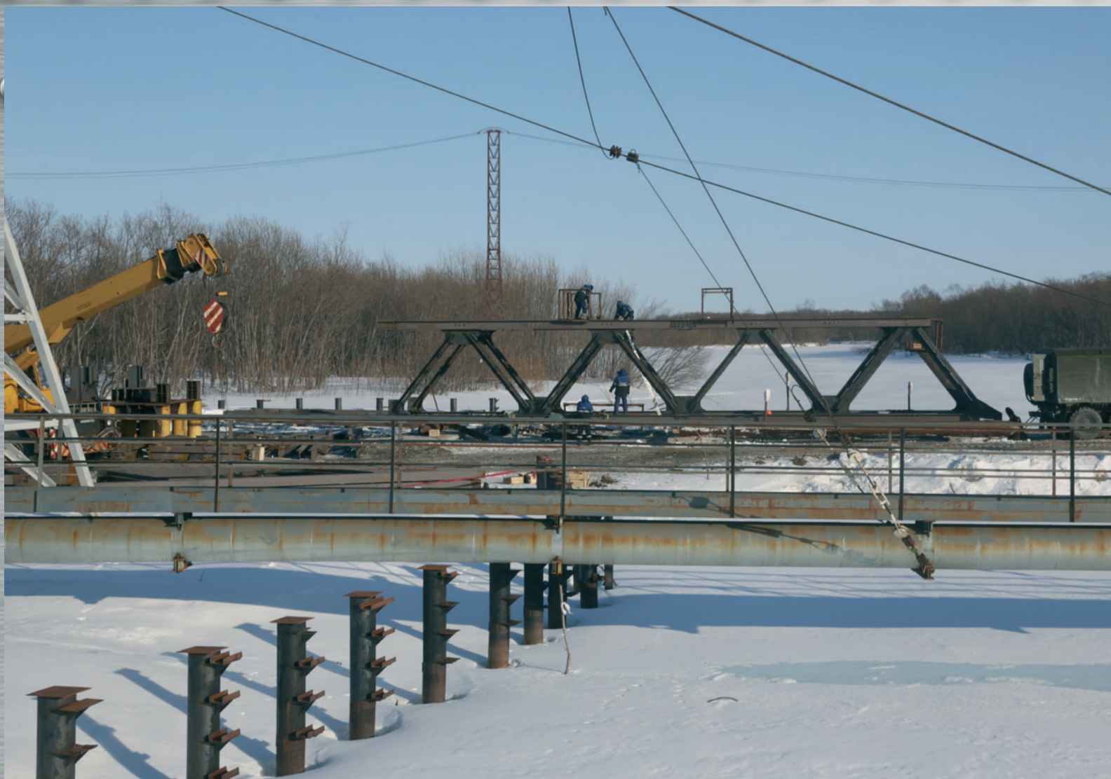
Строительство ферменного моста
