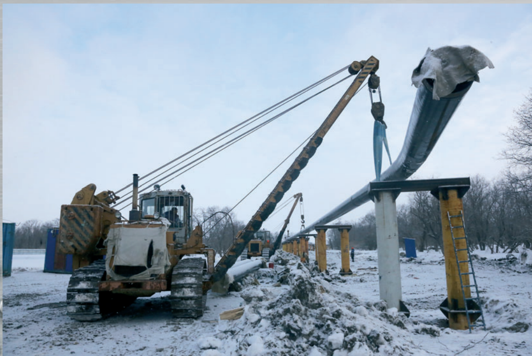
Установка трубы на свайные опоры
