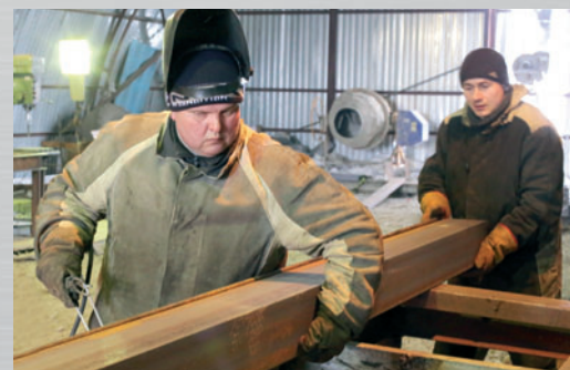
Заготовка усиленной фасадной части
