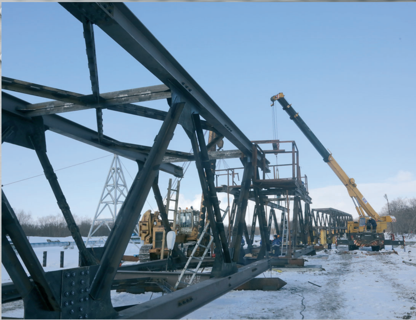
Монтаж фасадной части секции моста
