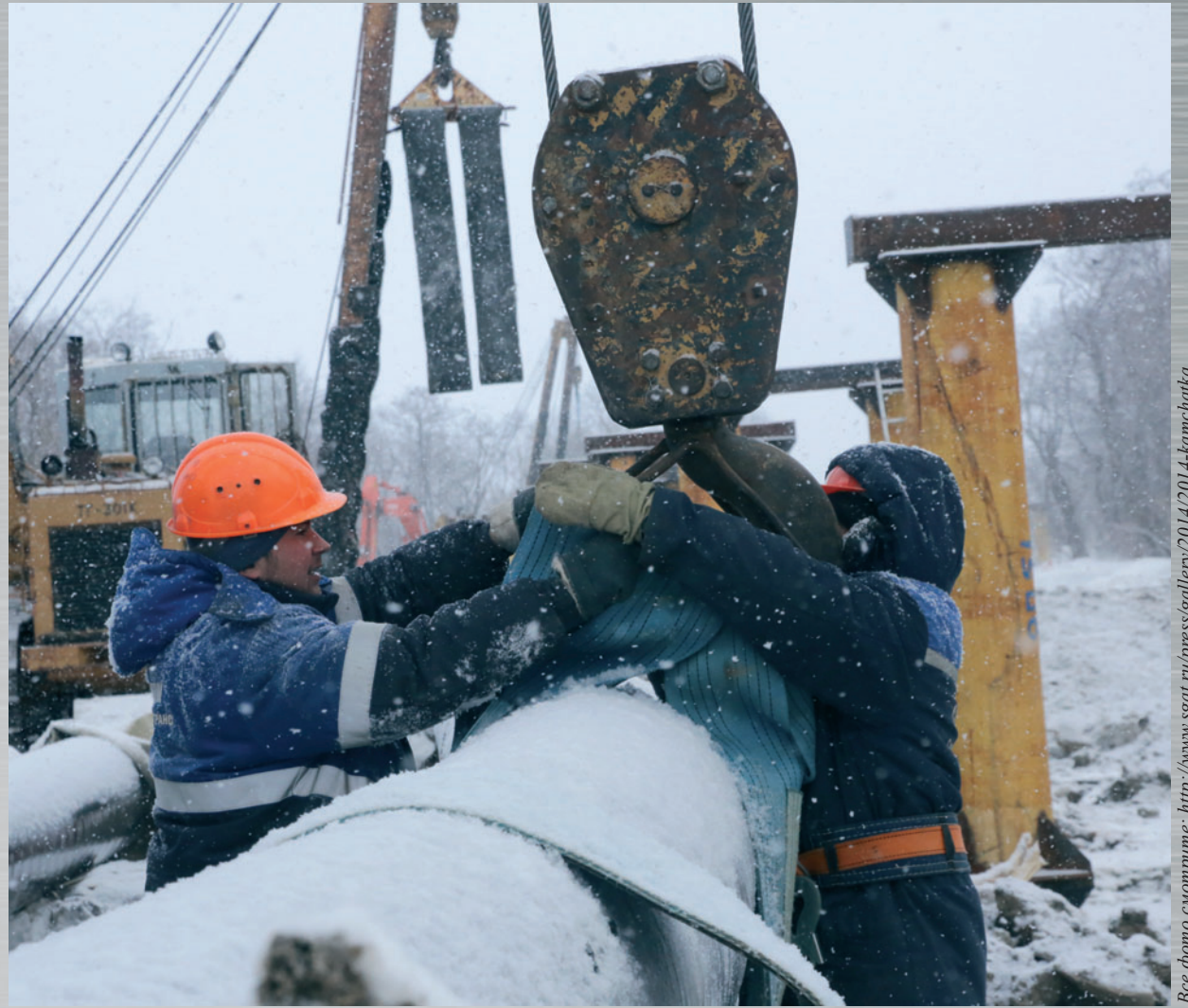
Строповка трубы
