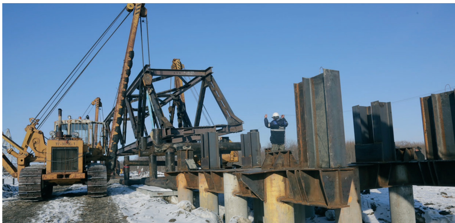
Установка секции ферменного моста через реку Колпакова
