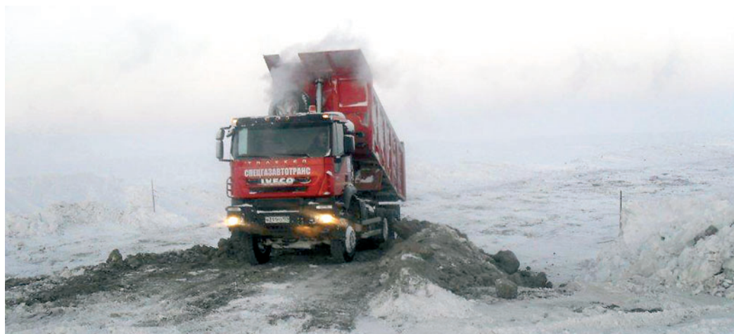
Отсыпка подъездной дороги к кусту №3 на Новопортовском НГКМ
