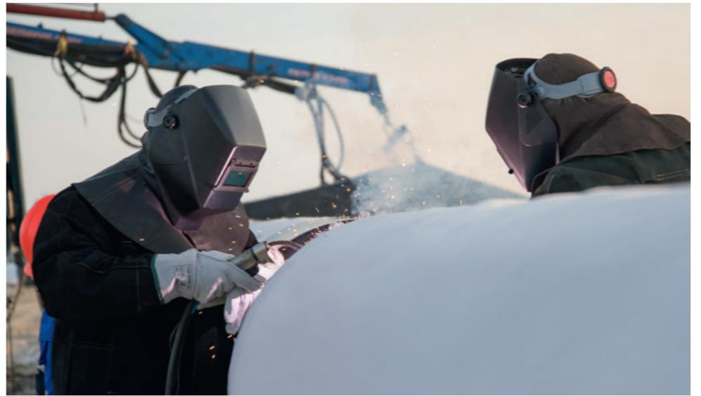
Сварочные работы на строительстве напорного нефтепровода
