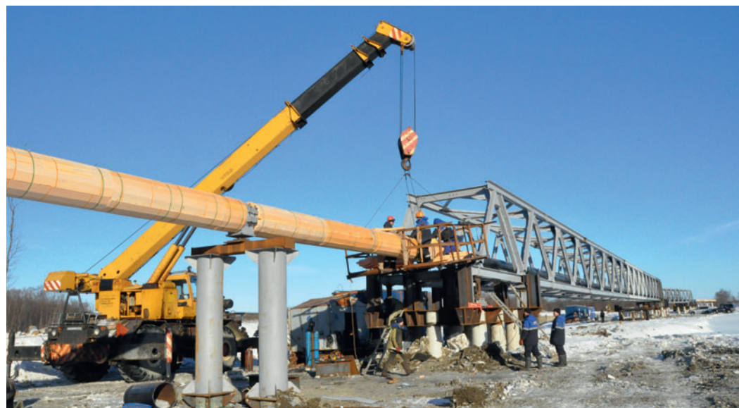
Капитальный ремонт МГ «УКПГ-2 Нижне-Квакчикского газоконденсатного месторождения – АГРС г. Петропавловска-Камчатского»
