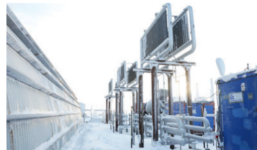
Система термостабилизации грунтов
