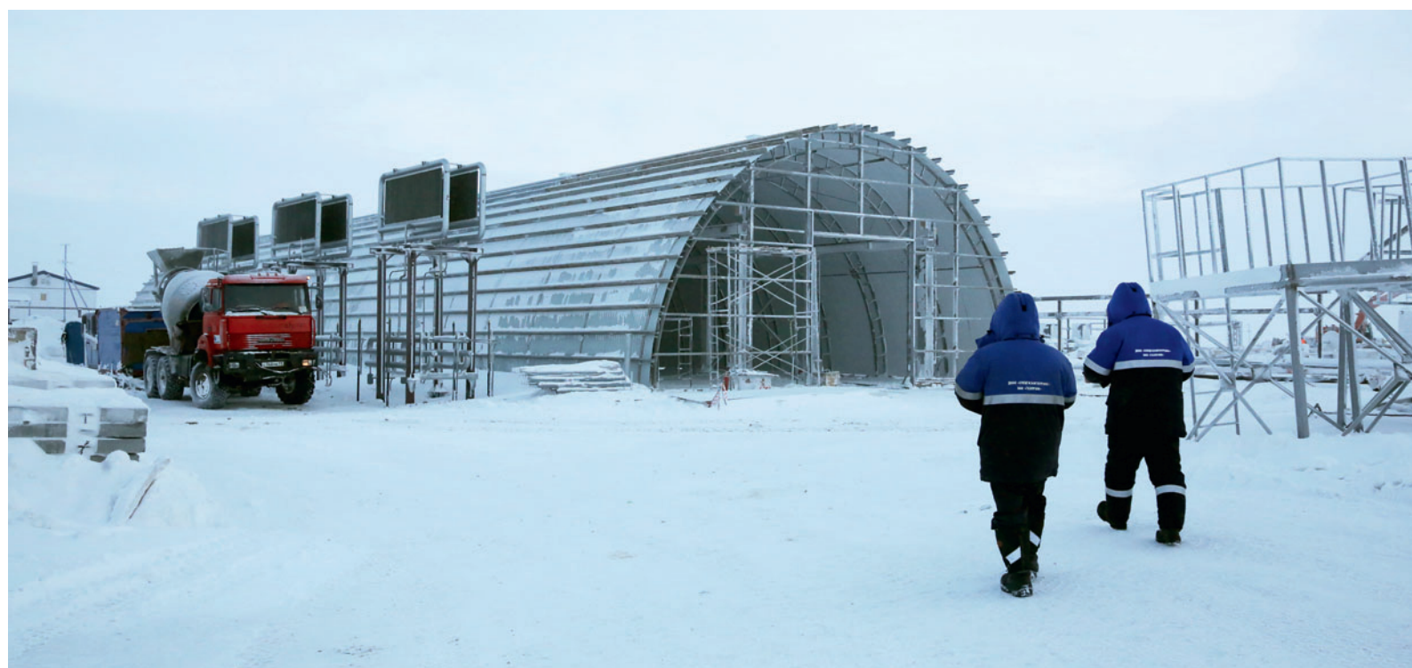
Строительство склада на площадке опорной базы промысла
