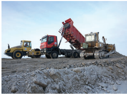
Отсыпка подъездной дороги
