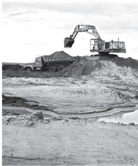
Погрузка грунта для отсыпки дорог (Ямал, 1990 г.)
