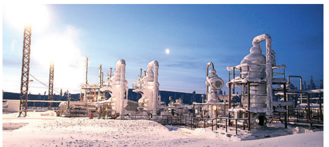
На газовом промысле Ковыктинского ГКМ
