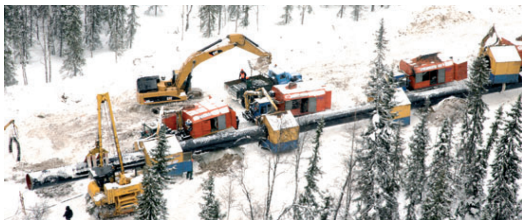
Строительство системы магистральных газопроводов «Бованенково — Ухта»
