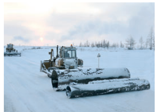
Уплотнение полотна автозимника волокушами
