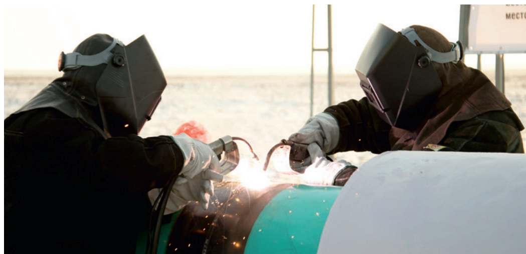
Сварка стыка трубопровода
