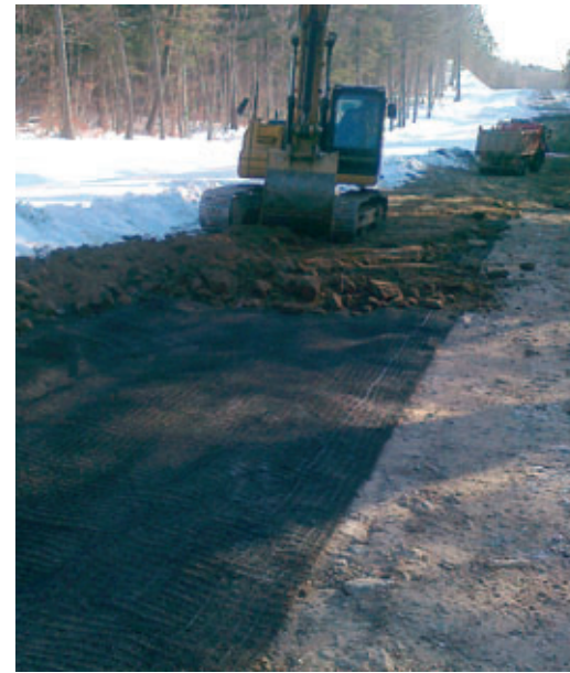
Работы по инженерной защите окружающей среды
