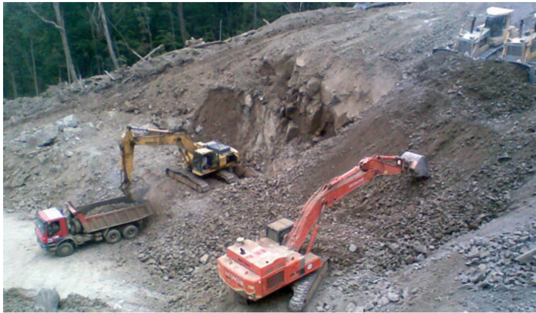
Срезка грунта на дороге к башне связи 59
