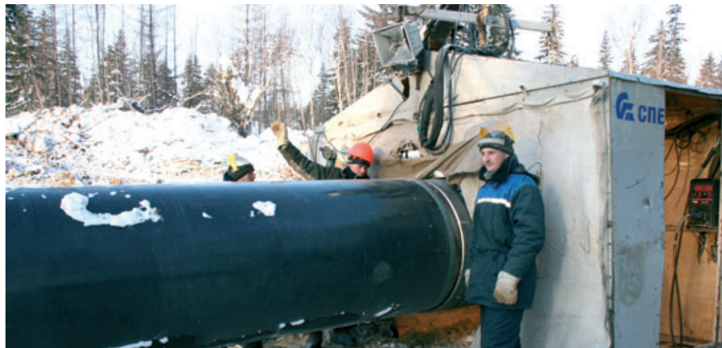
Строительство газопровода на острове Сахалин
