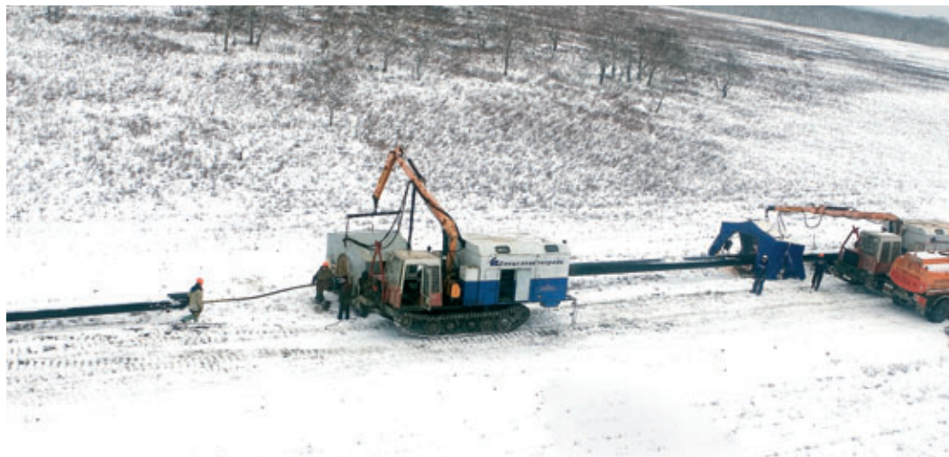
Строительство магистрального газопровода на Камчатке
