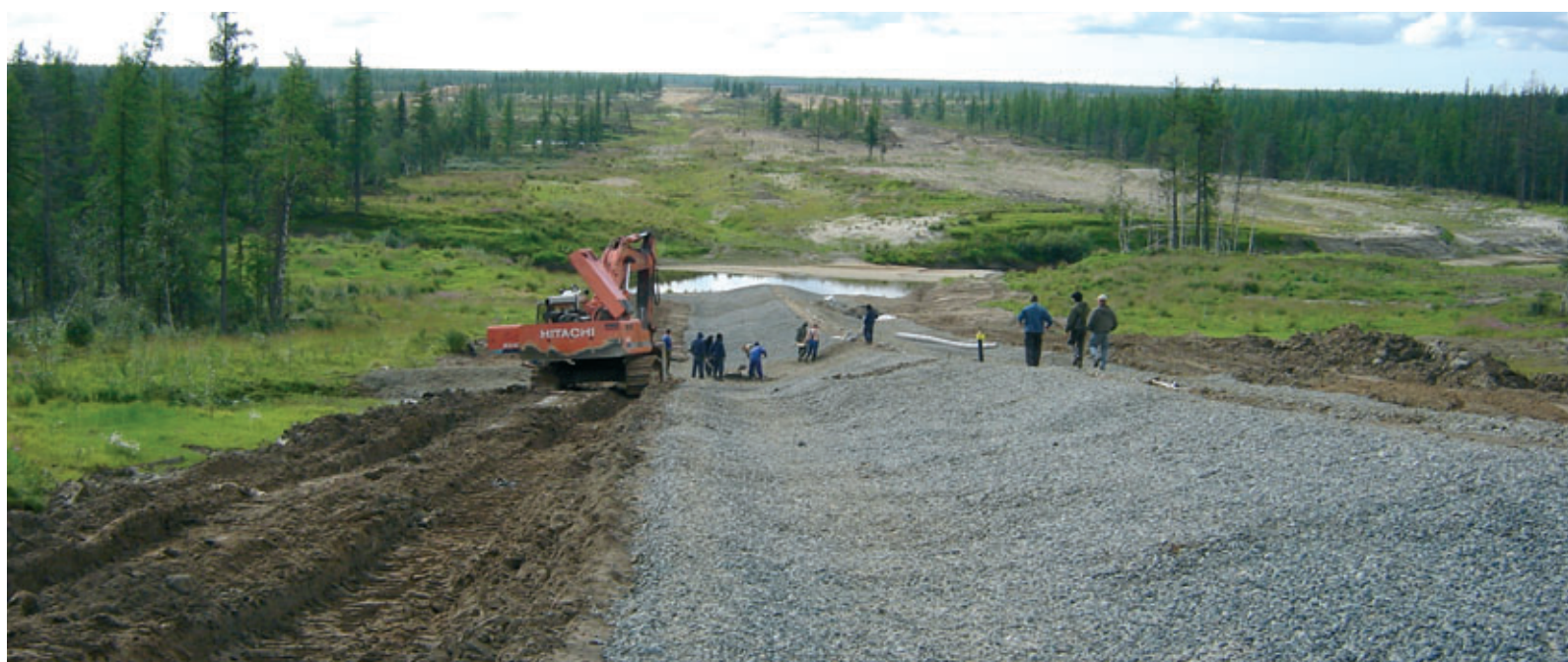
Устранение размывов обваловки на магистральном газопровode «Заполярье – Новый Уренгой»
