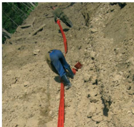
Прокладка кабеля для геотехнологического мониторинга газопровода
