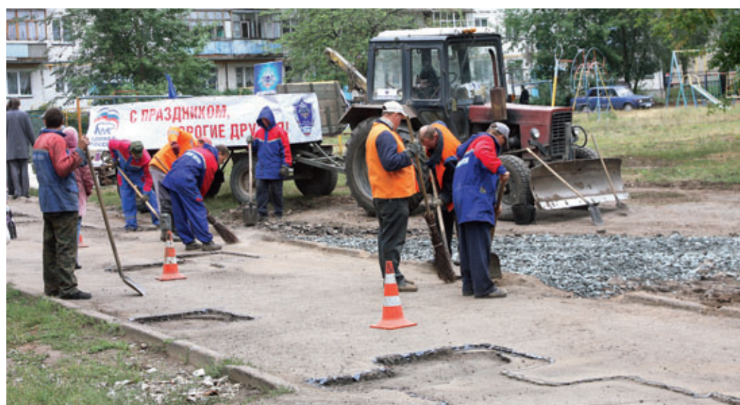
Ремонт дороги на улице Ворошилова по проекту «Новые дороги городам России»
