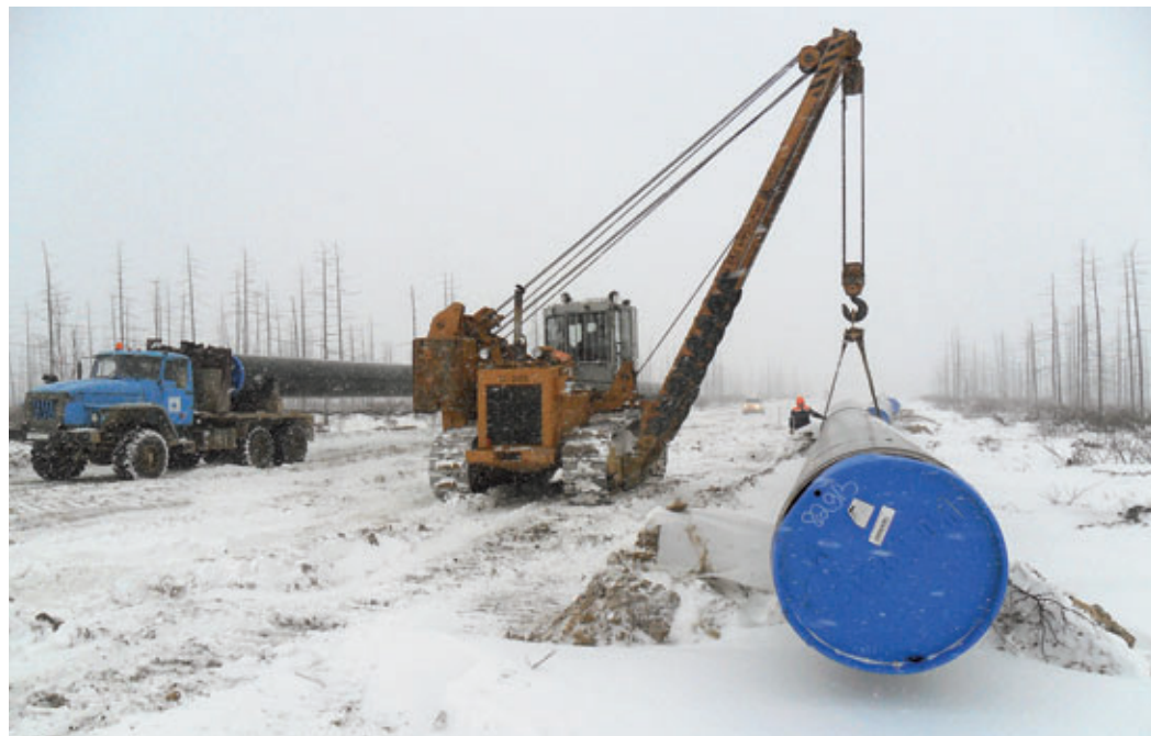
На Сахалине «Спецгазавтотранс» строит два участка магистрального газопровода
