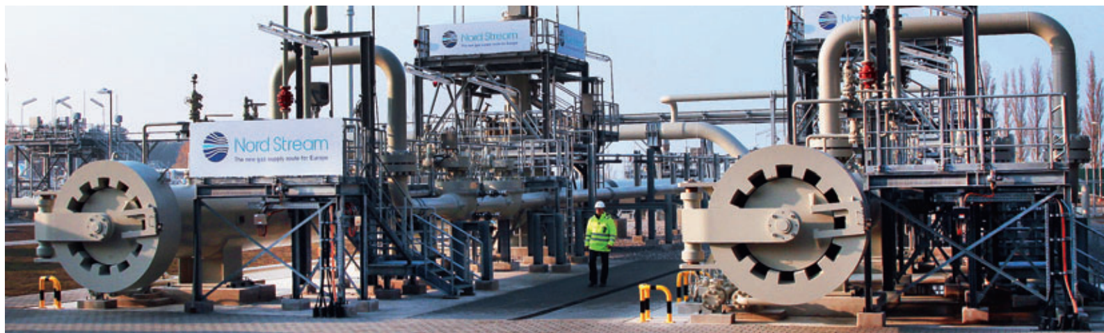
Ввод в эксплуатацию первой нитки газопровода «Северный поток»
