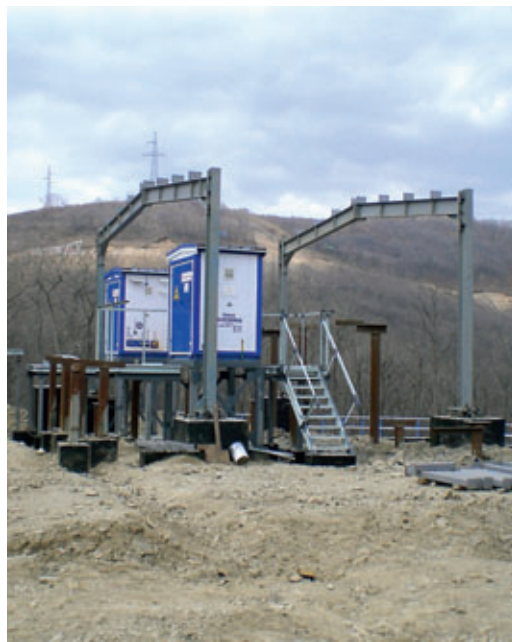
Строительство ГРС г. Владивостока
