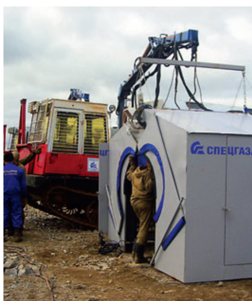
Строительство газотранспортной системы «Сахалин – Хабаровск – Владивосток»
