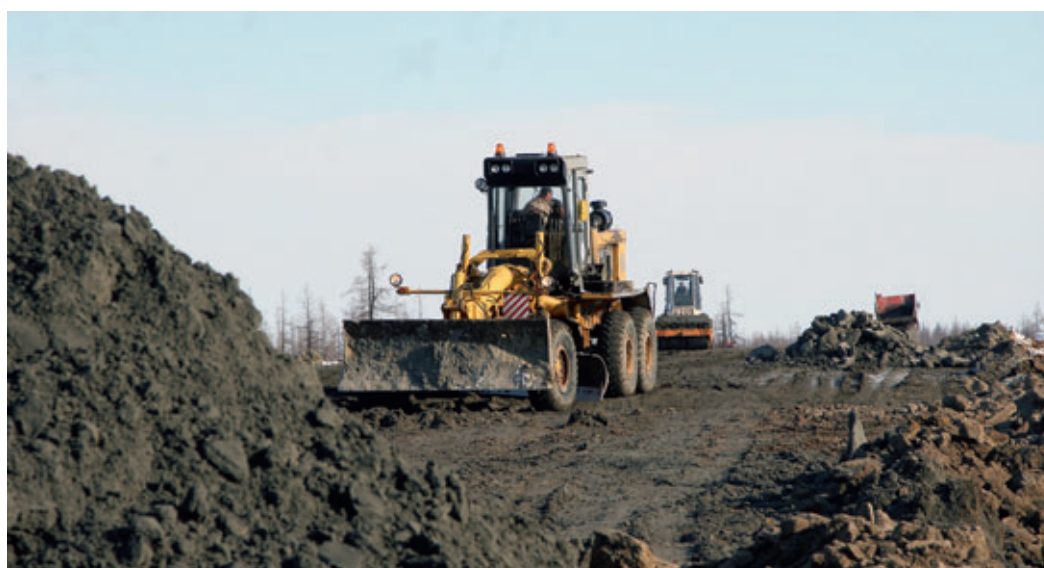
Строительство автодорог на Русском месторождении
