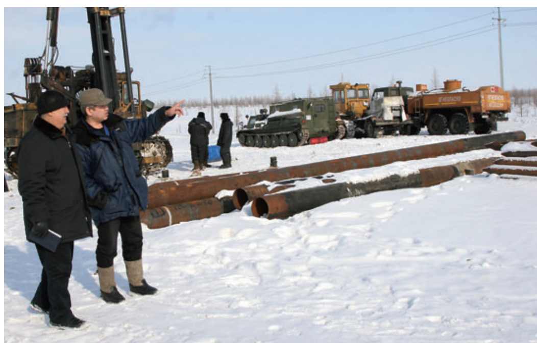
Строительство конденсатопровода «Заполярное - Новый Уренгой»
