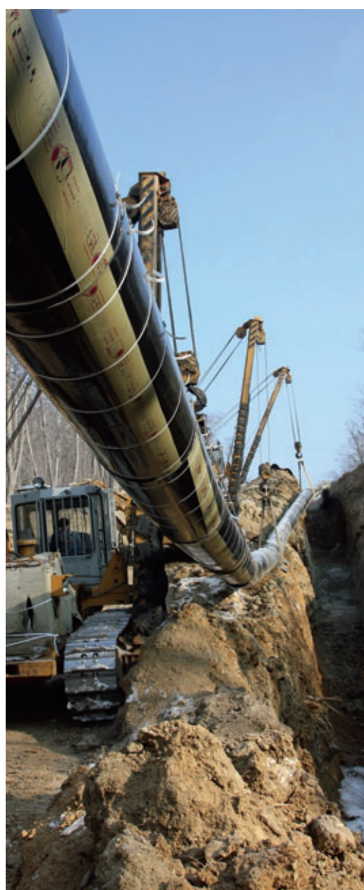
Строительство газопровода-отвода на г. Владивосток
