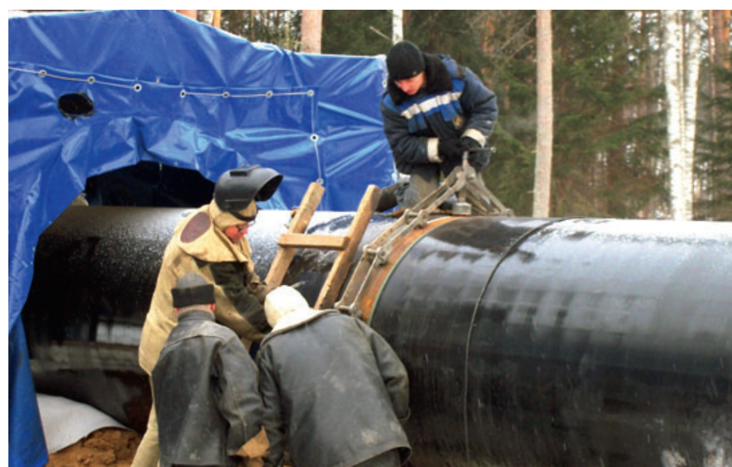
Строительство магистрального газопровода «Починки - Грязовец»
