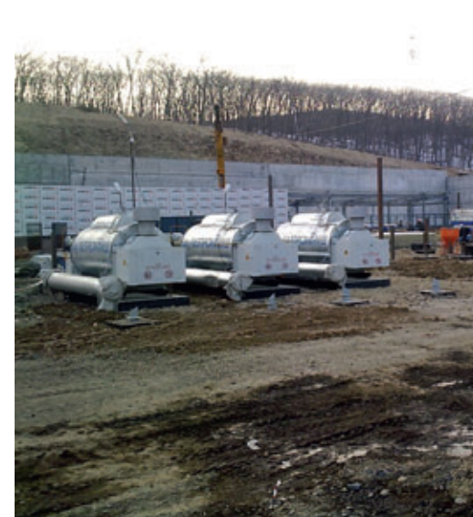
Строительство ГРС г. Владивостока
