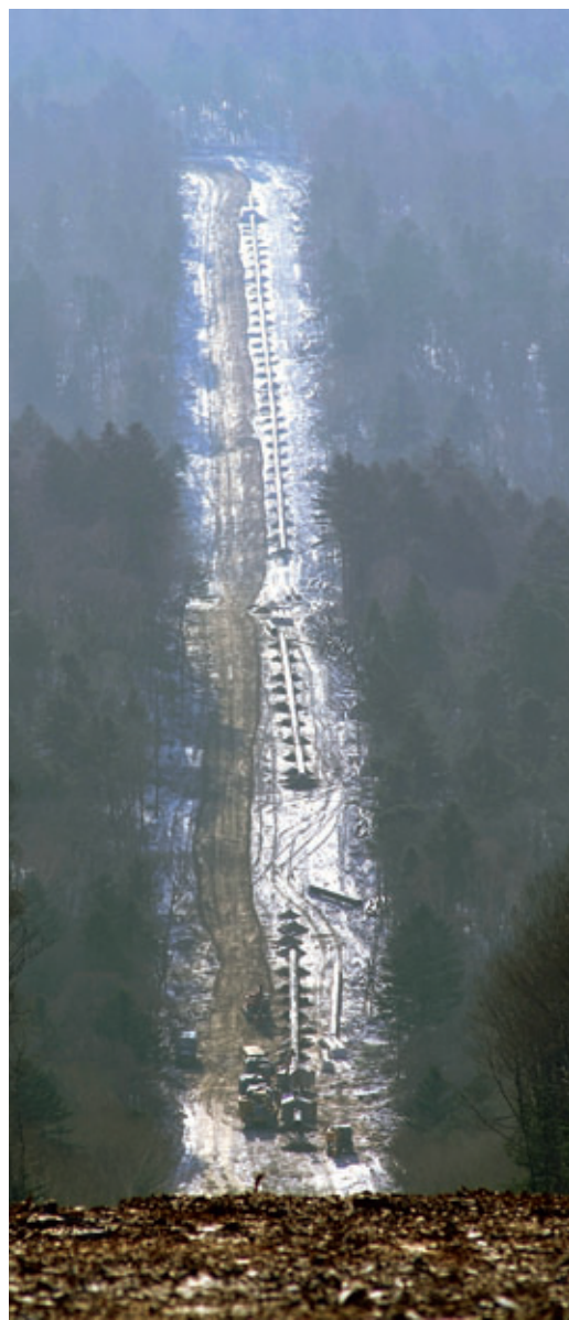
Строительство газопровода-отвода на г. Владивосток
