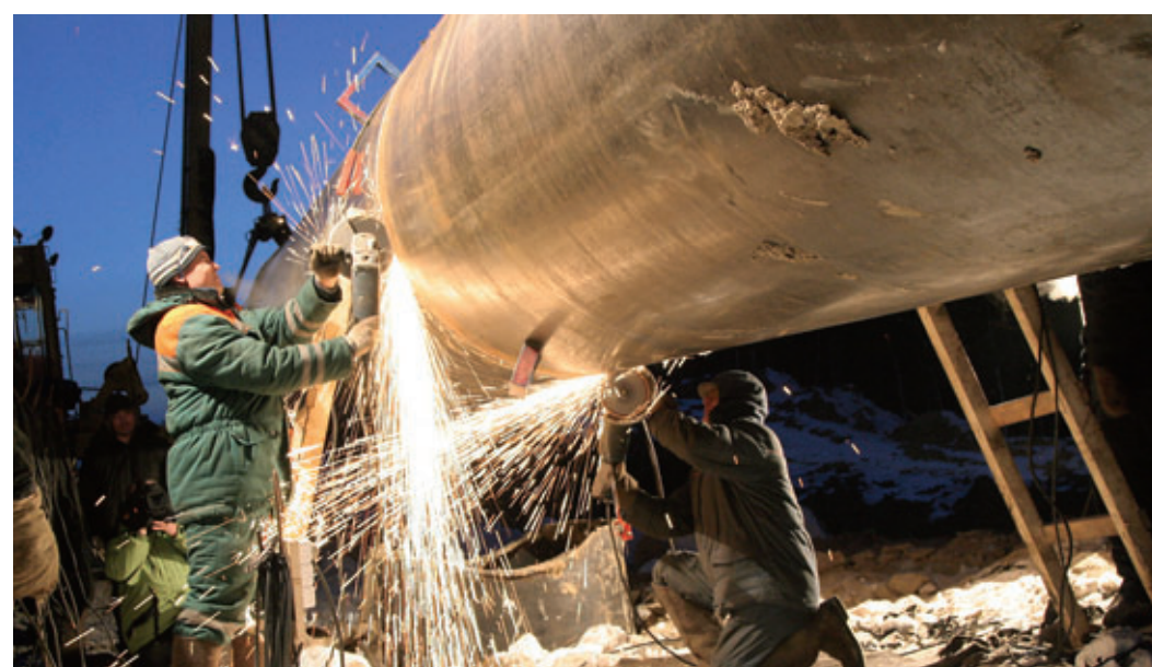
Капитальный ремонт магистрального газопровода «Комсомольское - Сургут - Челябинск»
