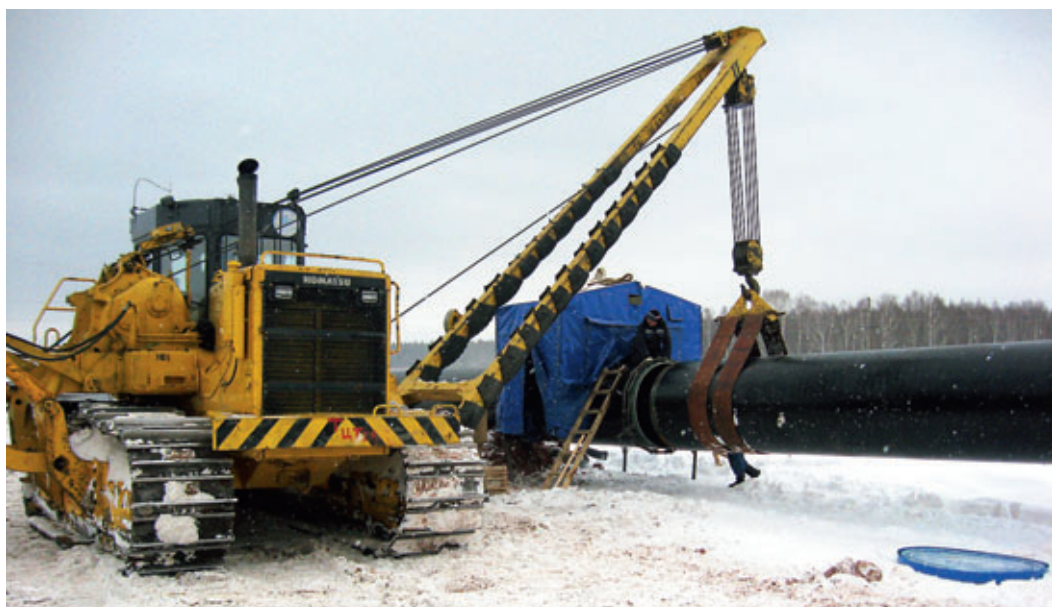
Строительство магистрального газопровода «Починки – Грязовец»
