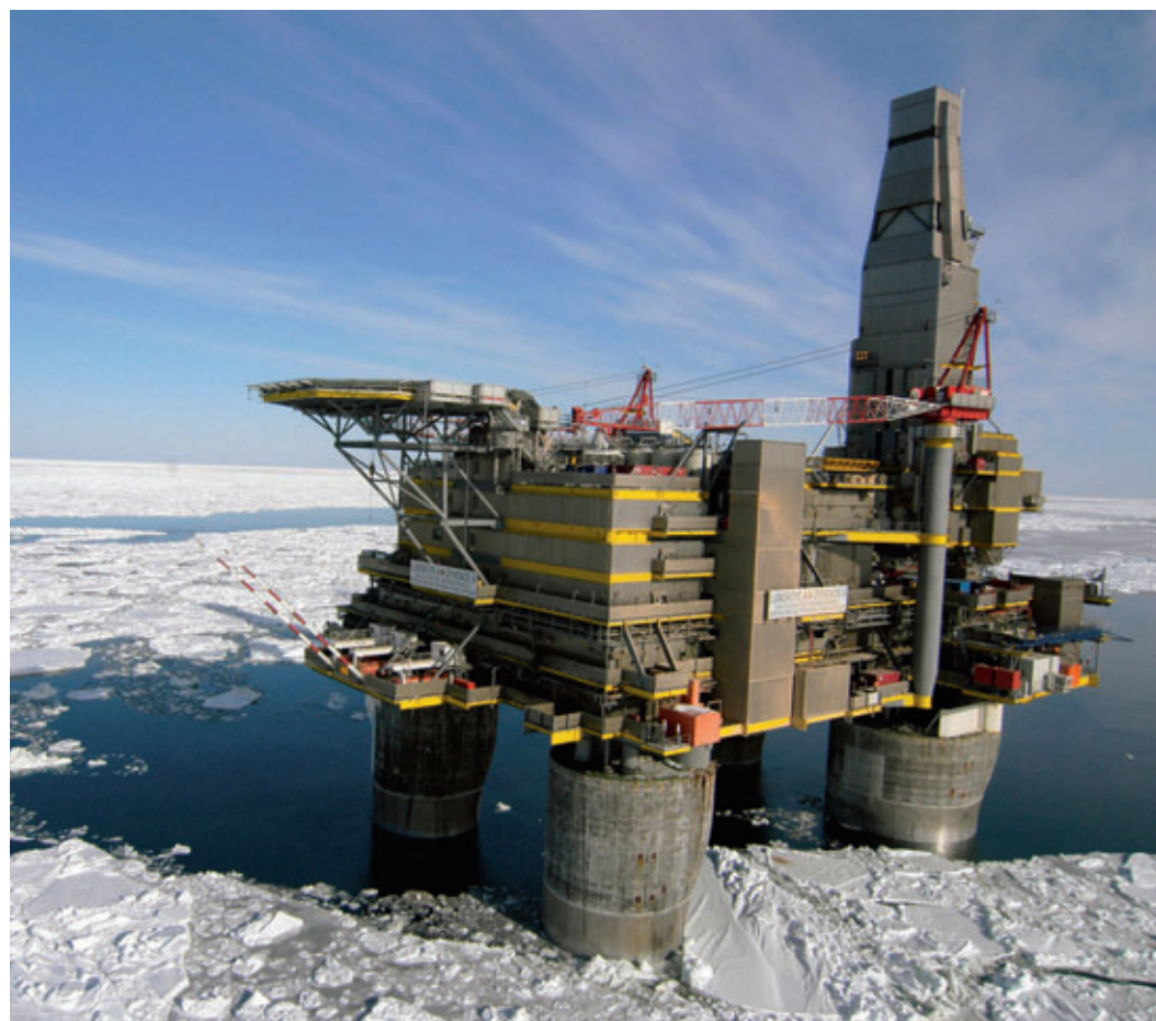
Буровая платформа на шельфовом месторождении проекта «Сахалин-2»
