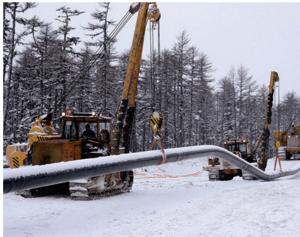
Строительство газопровода на Сахалине
