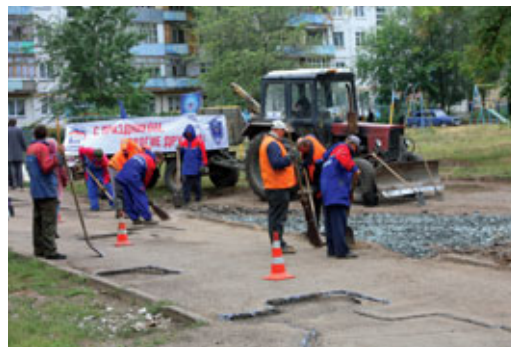
Ремонт на улице Ворошилова
