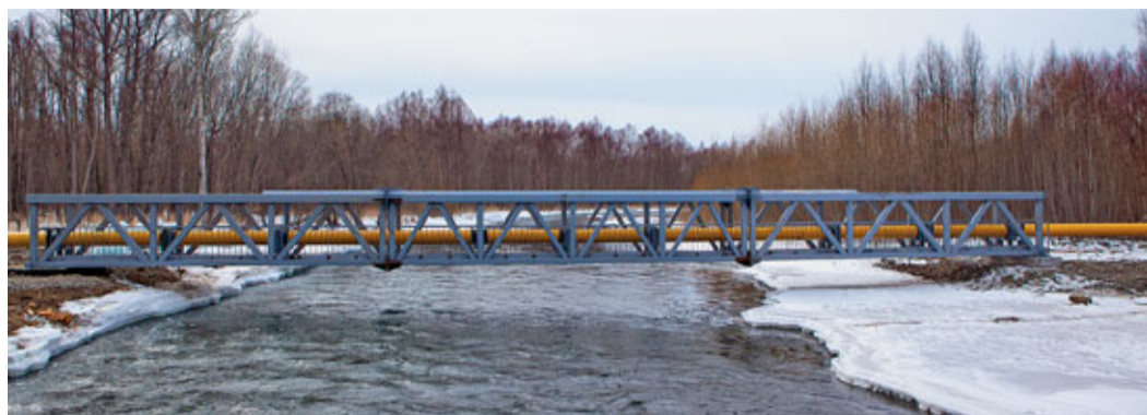
Воздушные переходы газопровода на Камчатке
