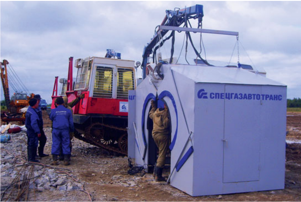
Подготовка сварочного оборудования
