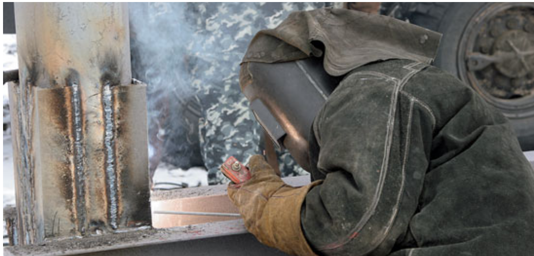
Сварка кранового узла
