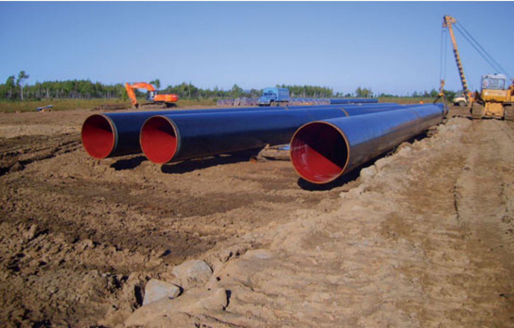
Подготовительные работы на переходе через реку Обор
