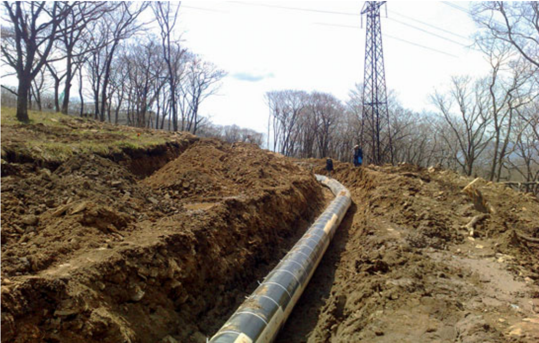
Межпоселковый газопровод от ГРС г. Владивосток до потребителей газа на о. Русский с отводом на ТЭЦ-2
