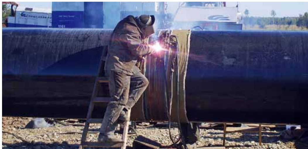
Сварка стыков на стеллаже
