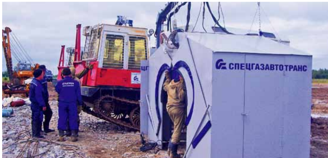
Подготовка к сварочному процессу
