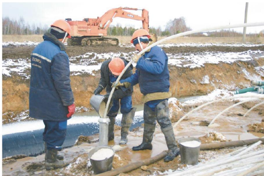
над работой установки облегчают полупрозрачные иглофильтры и наблюдения за сбросом воды.
