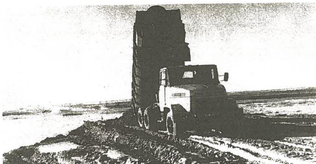
На снимке: отсыпка грунта под очередной объект. Для автотранспортников предприятий ДА «Спецгазавтотранс» газовые месторождения Крайнего Севера — это, прежде всего, отсыпка грунта под полотно новых автомобильных дорог, площадки под буровые и многочисленные строительные объекты.
