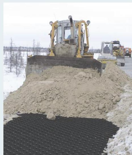
мерзлоты и таким образом уменьшить количество отсыпаемого грунта при устройстве земляного полотна дорог и площадок. Эта технология была успешно освоена, но специалисты до сих пор не пришли к единому мнению в отношении экономической эффективности укладки теплоизоляции. Дело в том, что «Пеноплекс» дорог, и его применение оправдывает себя только в том случае, если карьеры с качественным
