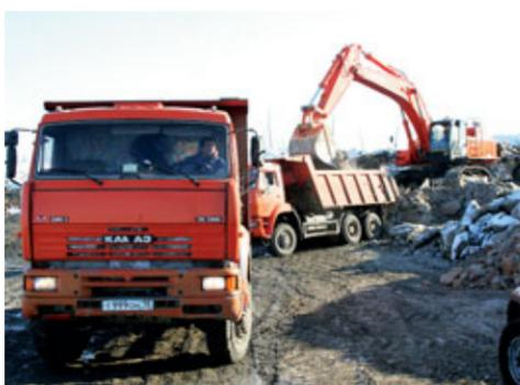
Строительство подъездной дороги 4 категории от Заплярного месторождения до базы Русского месторождения. На участке дороги длиной в 31 километр, было отсыпано 850 тысяч кубометров грунта.
