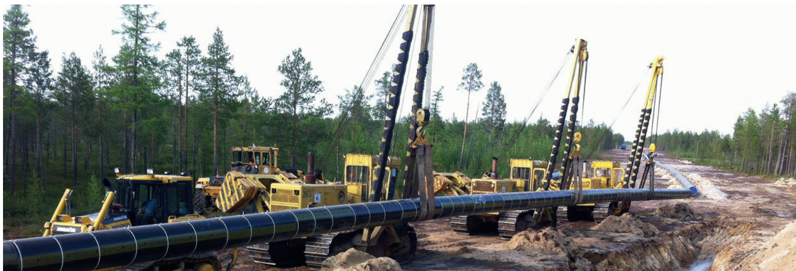
Строительство магистрального конденсатопровода «Уренгой – Сургут» (II нитка)
