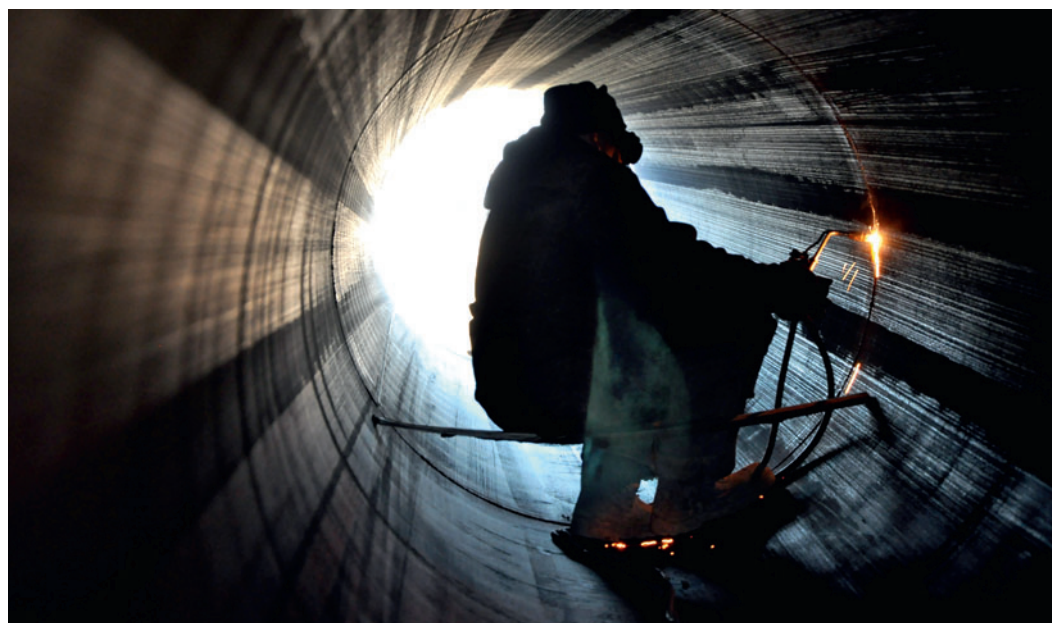
Сварка внутреннего шва в стыке трубы
