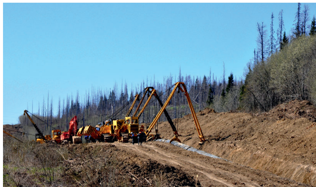
Капитальный ремонт МГ «Ямбург–Поволжье»
