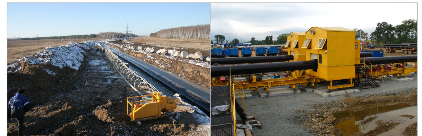
Иглофильтровая установка для водопонижения
