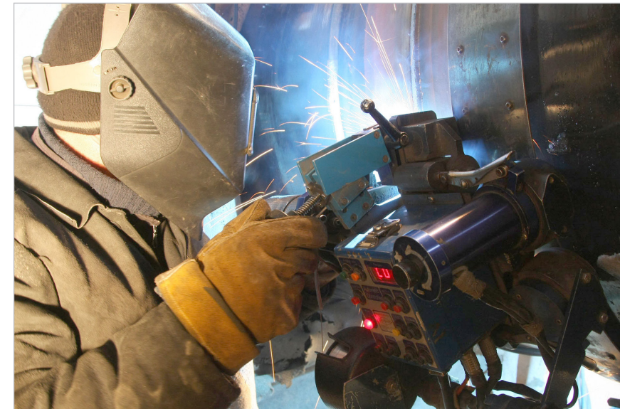
Автоматическая сварка стыка
